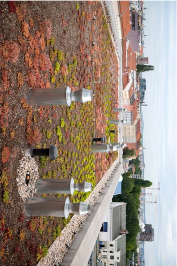
Obrázek 1 Zelená extenzivní střecha - Areál SVATOPETRSKÁ - rekonstrukce nováčního centra 2017-2019
